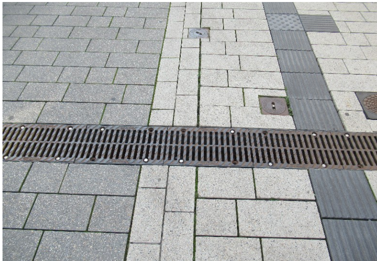
Bild 2: Entwässerungsrinne mit einer Abdeckung, die Bodenindikatorprofile aufweist © Mobilfuchs
