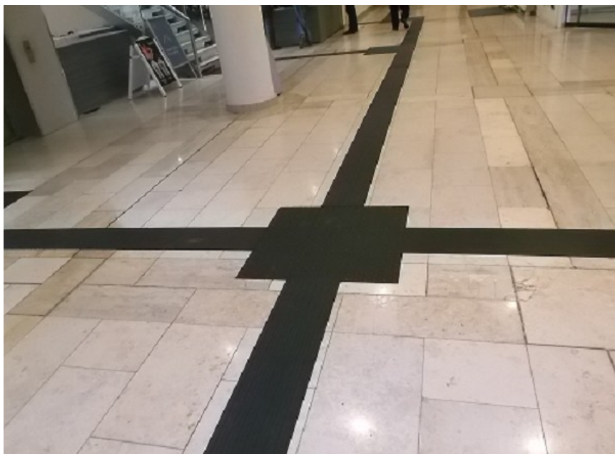
Bild 4: Dunkles Blindenleitsystem auf hellem Bodenbelag © Mobilfuchs
