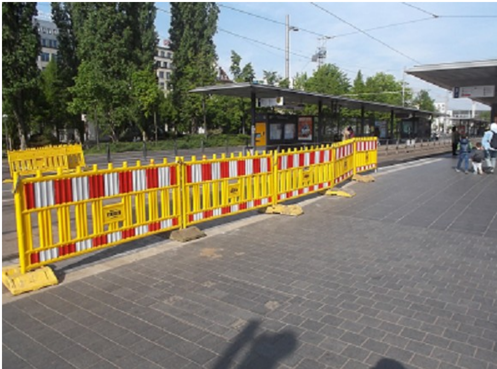
Bild 5: Mit dem Blindenlangstock rechtzeitig taktil wahrnehmbares Baustellenabsperngerät © Mobilfuchs
