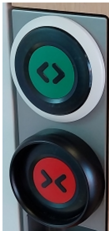
Bild 10: elektronischer Türöffner und -schließer mit erhabenen Pfeiltasten
