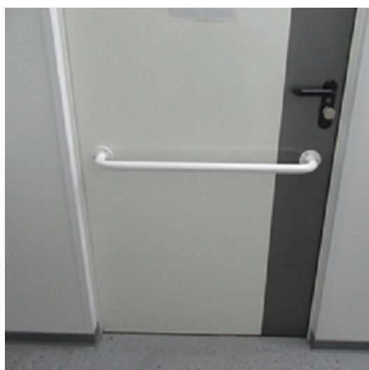
Bild 7: Tür einer barrierefreien Toilette mit Zuziehstange © Mobilfuchs
